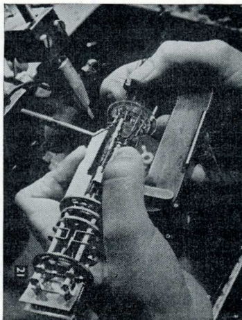
Fig. 16. Het lassen van het binnenwerk aan de glazen voet.
