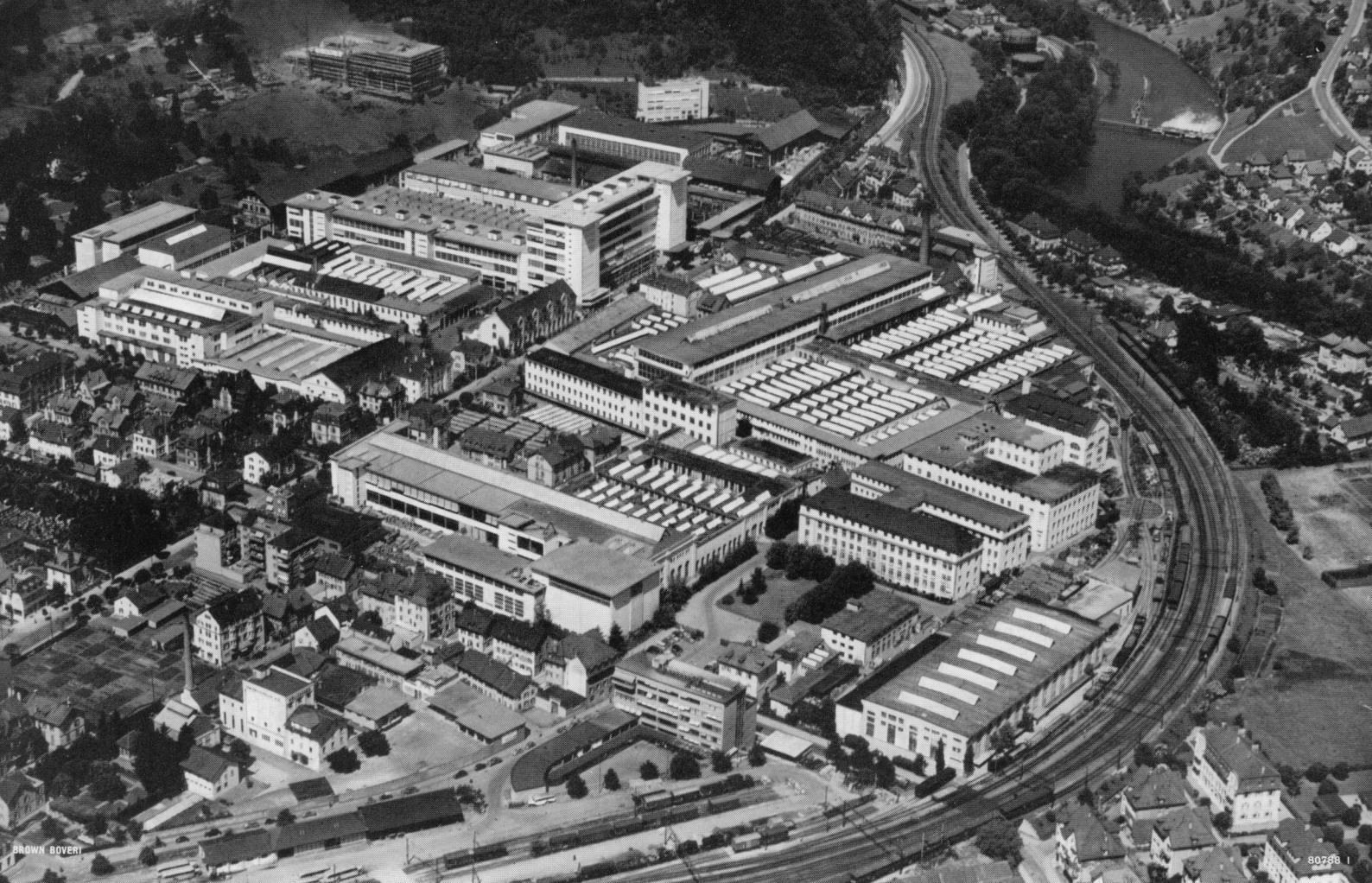
Vue aérienne des usines de la Société Anonyme Brown, Boveri & Cie à Baden (Suisse)
